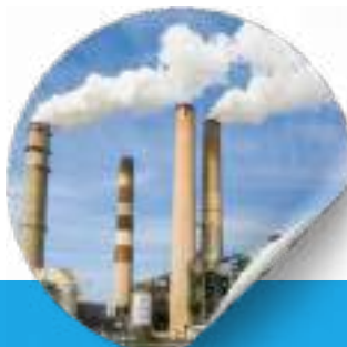
DEPURADORES DE HUMO
