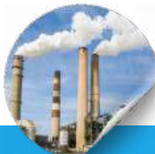
DEPURADORES DE HUMO
